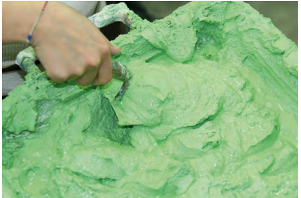
Intonaco per strato superficiale, più fluido.
