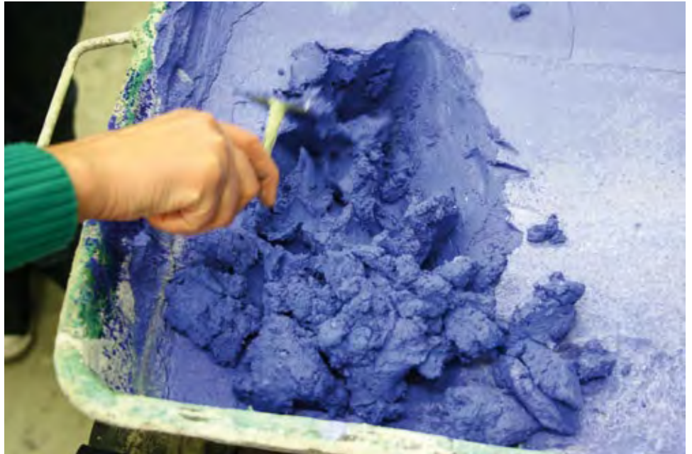
Intonaco di base per primo strato.
