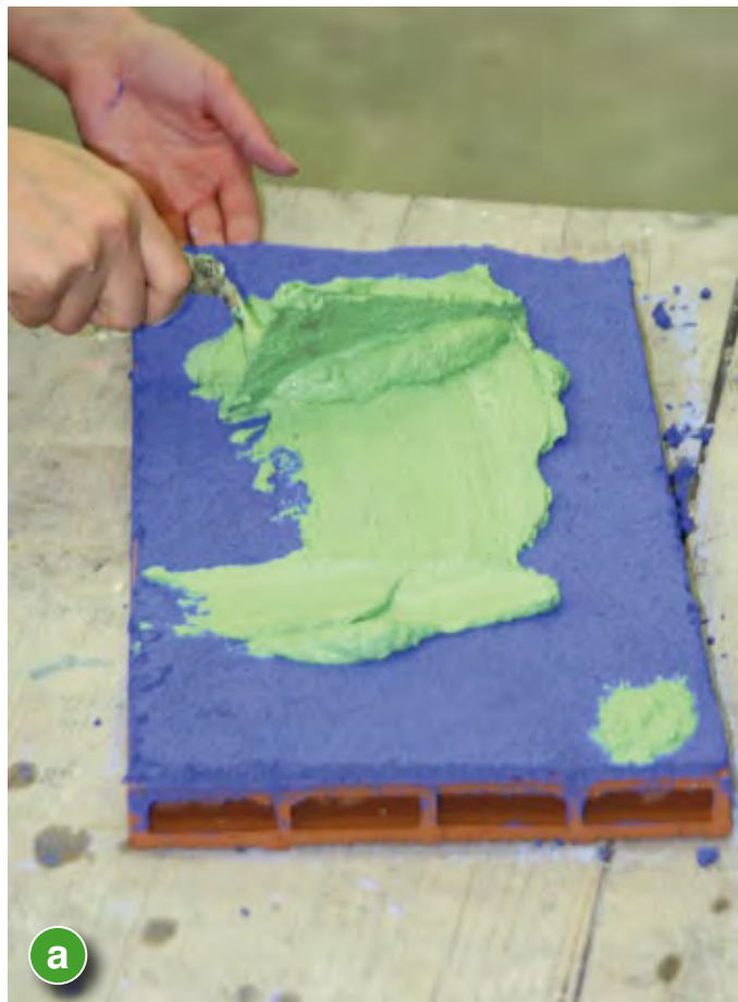
3 - Stesura del secondo intonaco con la cazzuola.
