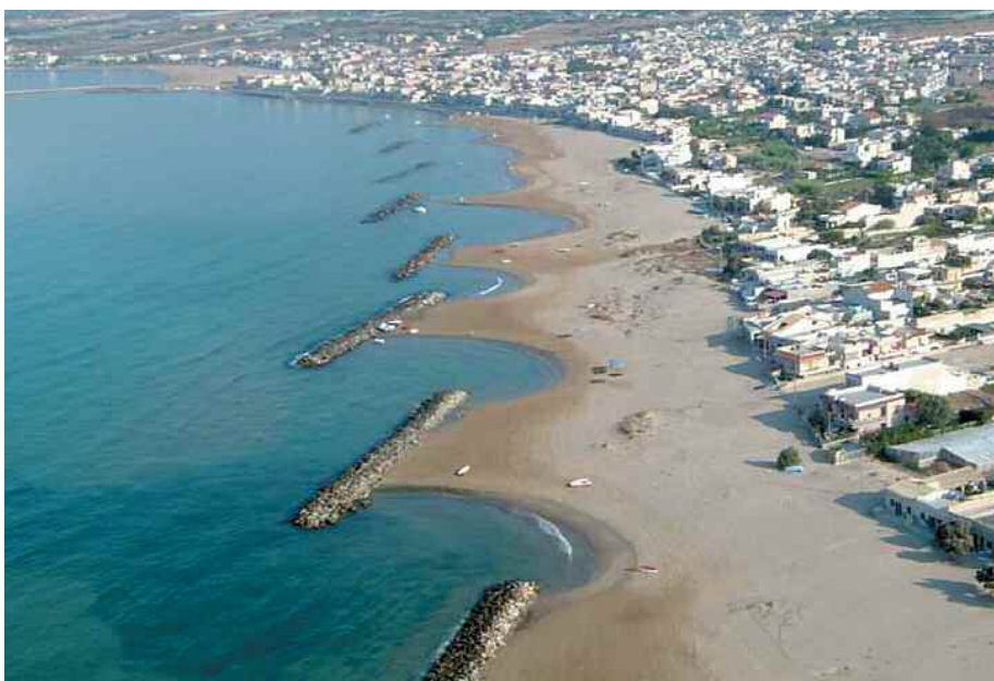
Fig. 1. Frangiflutti per la salvaguardia della spiaggia disposti lungo la costa di Donnalucata (frazione del comune di Sciacca, Ragusa).
