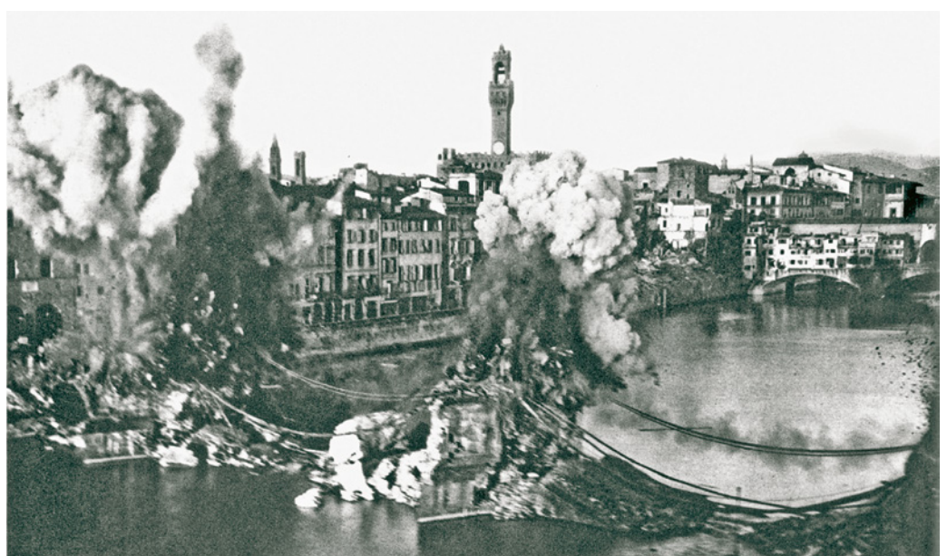
Fig. 2 La distruzione dei ponti sull'Arno a Firenze compiuta dai tedeschi nell'agosto 1944, poco prima di abbandonare la città, liberata dai partigiani e dalle truppe alleate.
