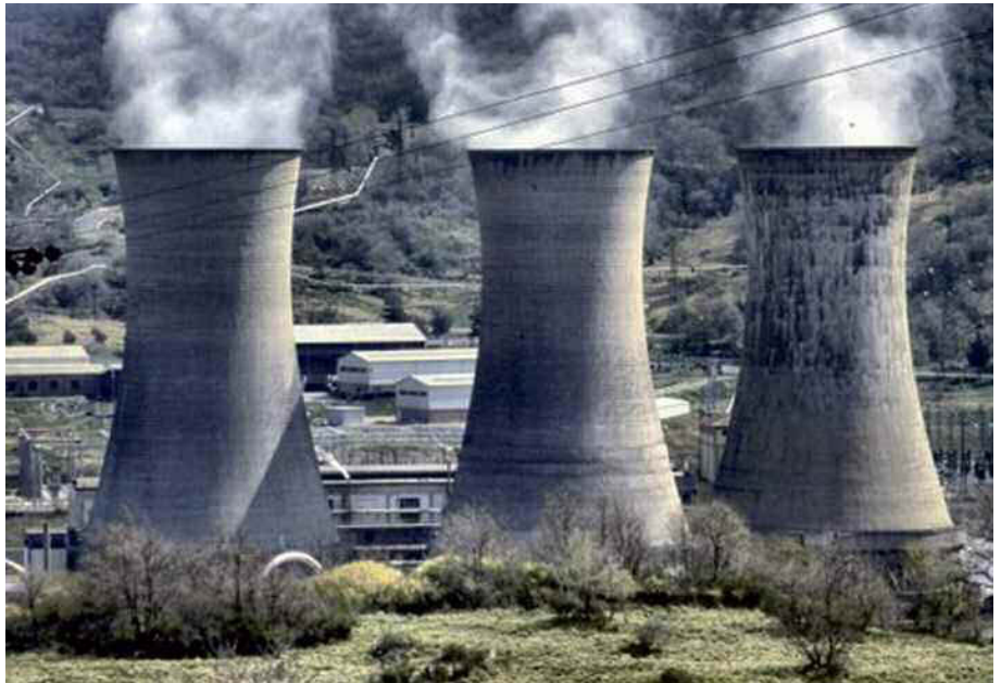
Fig. 2. Particolare della centrale geotermoelettrica di Larderello, con in primo piano alcune delle torri di raffreddamento dove condensa il vapore del circuito che alimenta il turboalternatore dell'impianto (foto: Roberto Tomei).
