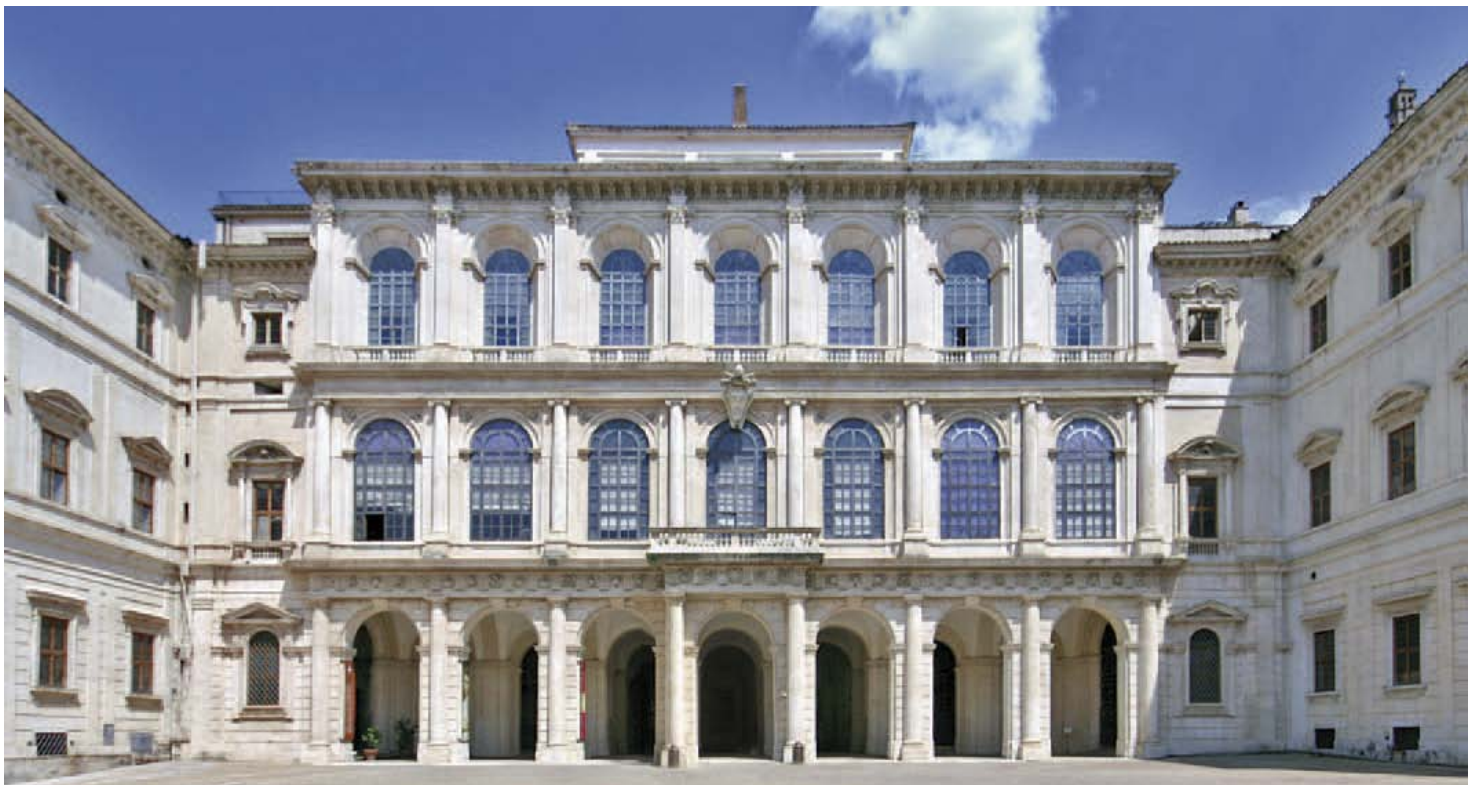
Fig. 2 C. Maderno, G.L. Bernini, F. Borromini, Palazzo Barberini, 1626-1630. Façade facing via delle Quattro Fontane. Rome.
