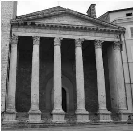
Prospetto del romano Tempio di Minerva ad Assisi. I plinti emergono dalla scalinata d'accesso.
