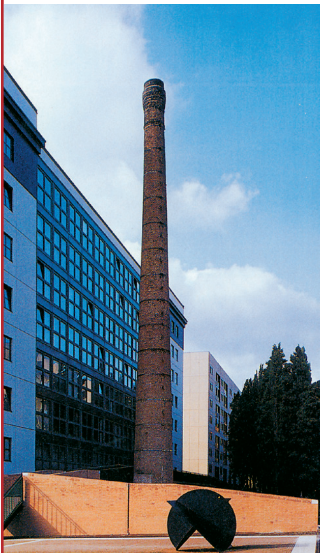
La ciminiera della prima fabbrica della Perugina, conservata all'interno del recupero architettonico del quartiere di Fontivegge, a Perugia, opera dell'architetto Aldo Rossi.
