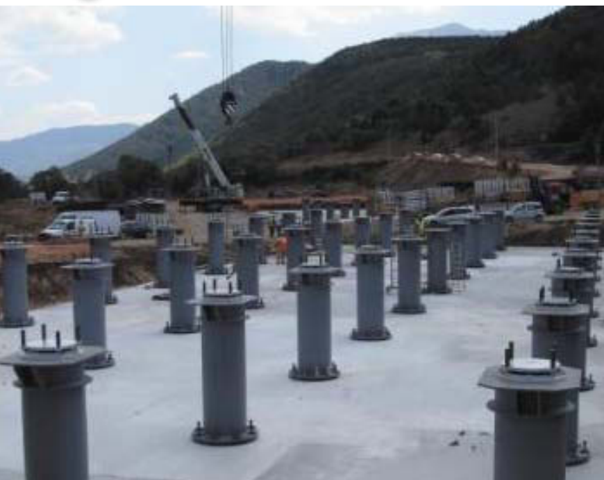
Fig. 2. Posa di dissipatori per una casa antisismica.
