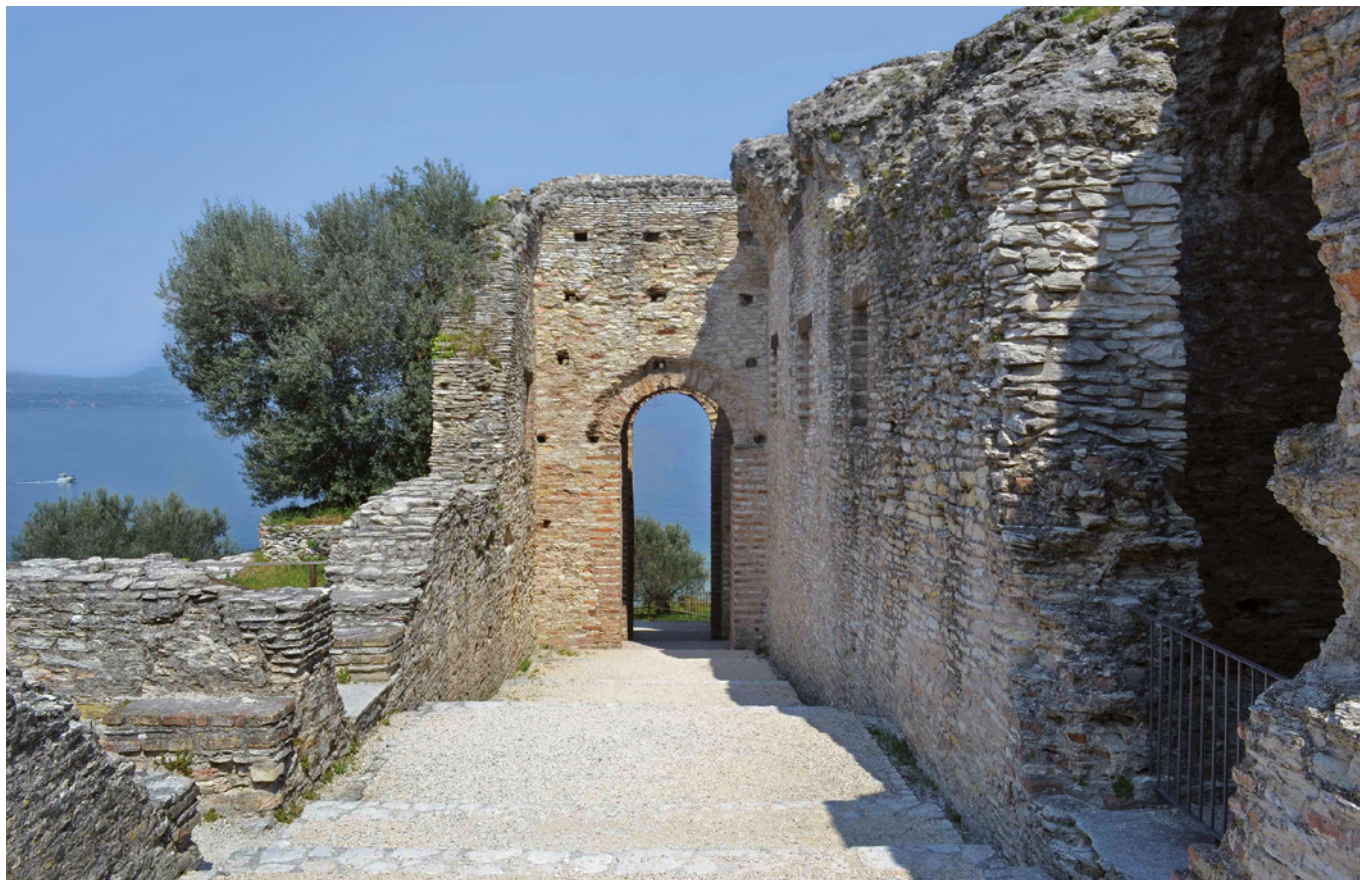
Fig. 3 Grotte di Catullo, fondazioni al primo livello e rampa orientale.
