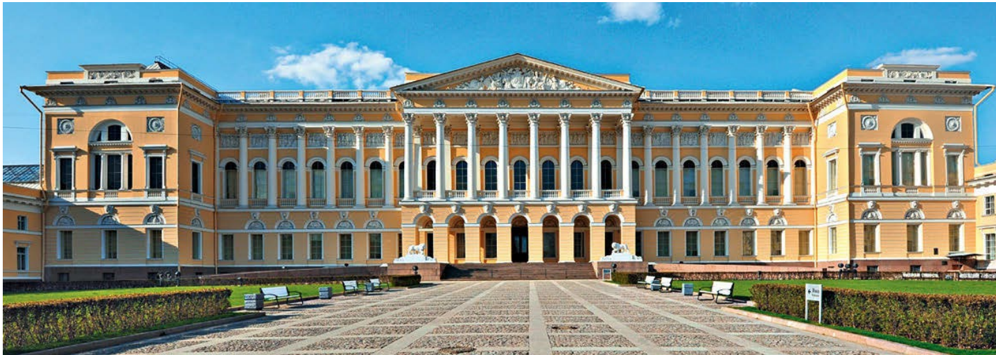
>> Carlo Rossi, Palazzo Michajlovskij , 1819-1825. San Pietroburgo. Facciata sulla Piazza delle Arti.
