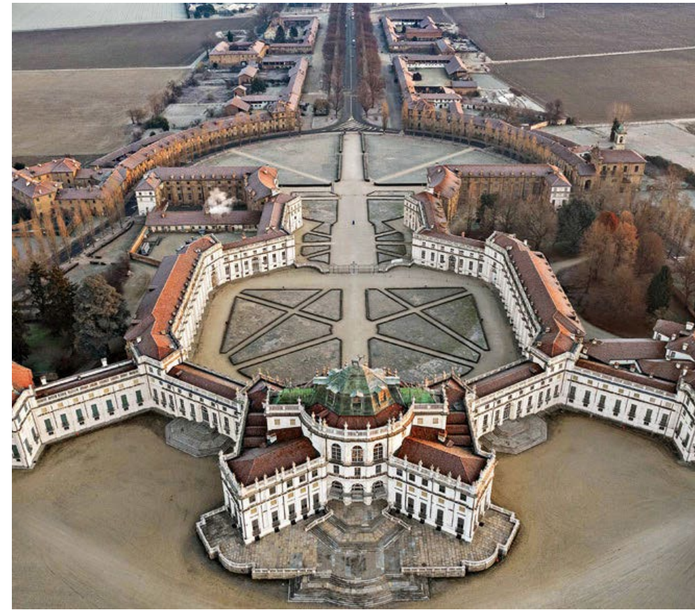
>> Filippo Juvarra, Palazzina di caccia di Stupinigi , 1729-1733.
